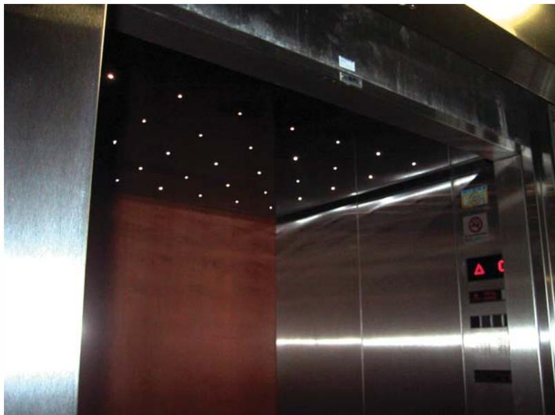
Una de las aplicaciones más habituales para este generador, es para la iluminación de cabinas de ascensores mediante fibra óptica.
